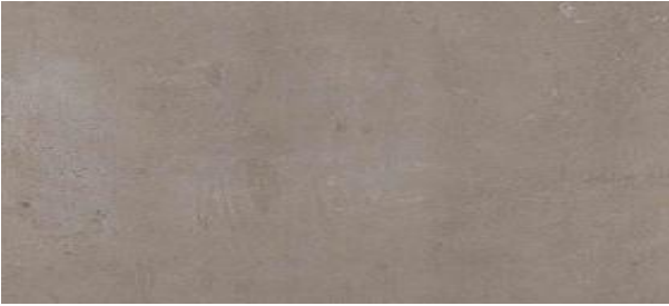
F274 ST9 Beton deschis
